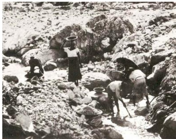
การทำเหมืองทองคำแบบเหมืองหาบขนาดเล็กโดยการใช้แรงงานคน
