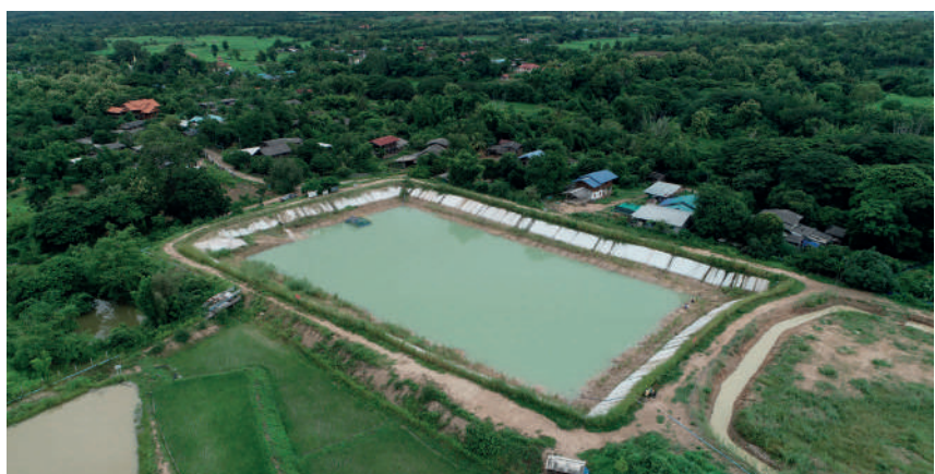
บ่อกักเก็บน้ำบ้านแม่ทาน ความจุ 50,000 ลูกบาศก์เมตร รองรับน้ำจากระบบสูบน้ำพลังงานแสงอาทิตย์ (Solar Floating) จากบ่อเหมืองแม่ทาน จังหวัดลำปาง
