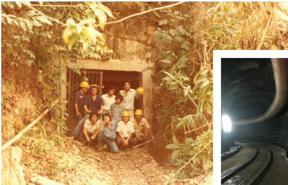
งานอุโมงค์ส่งน้ำที่เชียงใหม่
